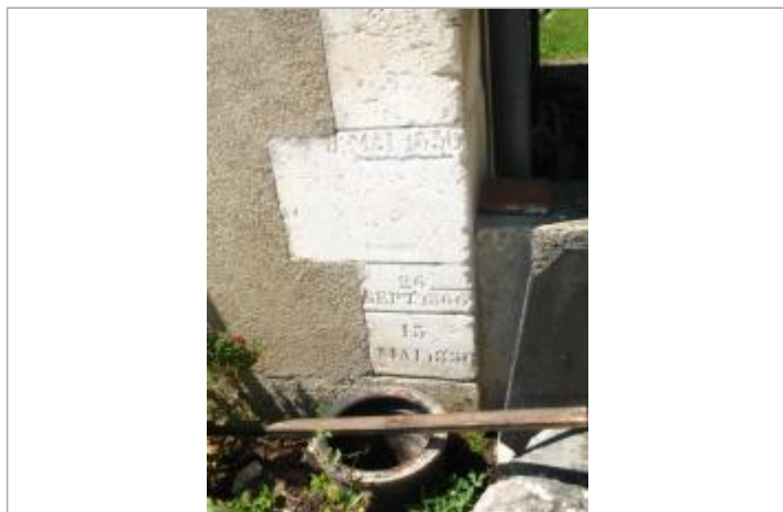
Repère de crue septembre 1866 - auteur photo : DIREN IDF
