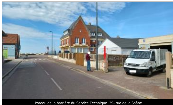
Poteau de la barrière du Service Technique. 39- rue de la Saône
