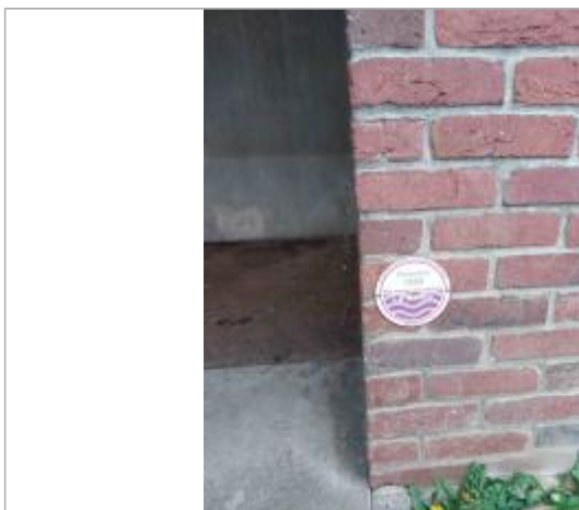
Vue sur le repère normalisé, sur le mur droit de l'ancienne entrée (source : B2HPC SACN)
