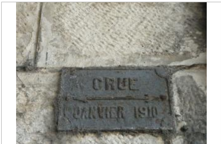
PILIER SNCF RUE DU 8 MAI 45 - auteur photo : SLB
