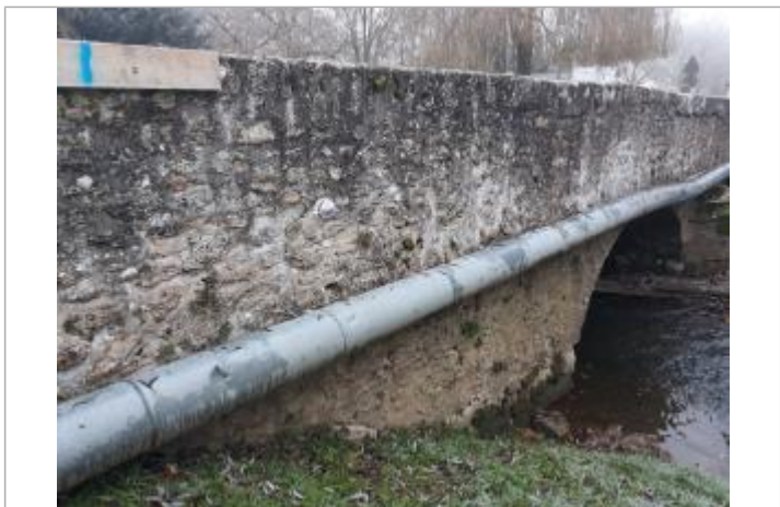
Repère de crue - Seine et Marne Environnement
