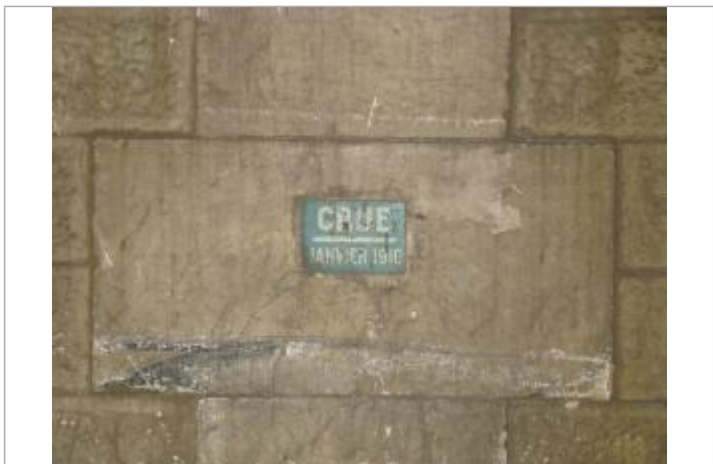
Repère de crue \"Crue janvier 1910\". Tunnel Proudhon. Paris, 12e. - auteur photo : MULLER Marc
