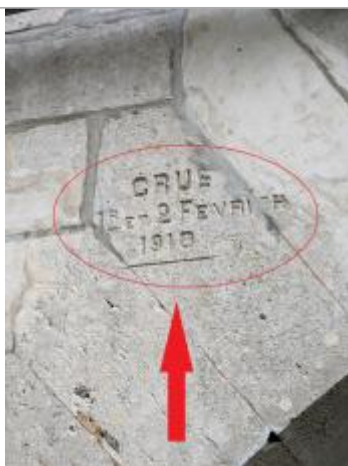
Vue de la marque gravée sur l'arche du pont.
