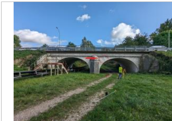
Vue du pont, en bas depuis le coté aval.
