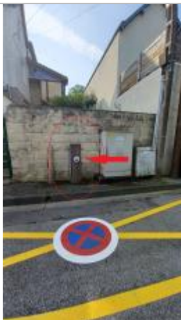
Laisse de crue à 62 cm/sol.
