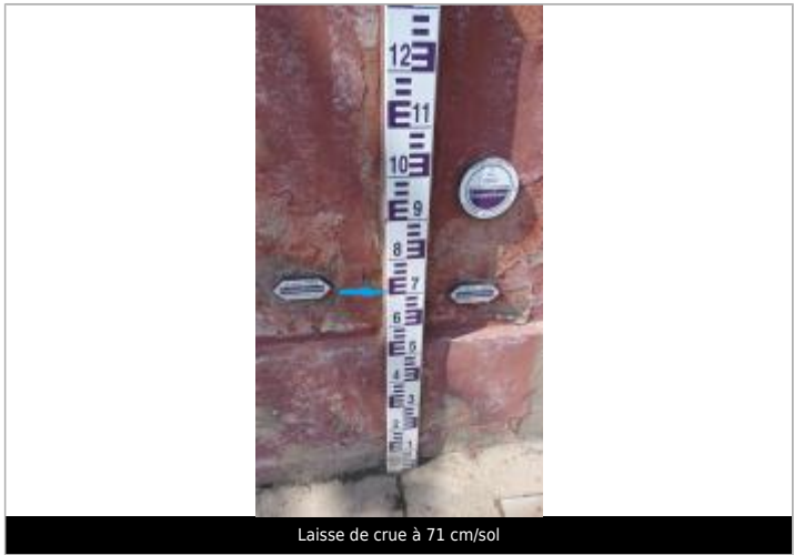
Laisse de crue à 71 cm/sol
