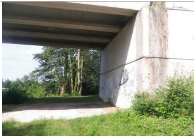
Le pont de Port Montain - auteur photo : SAFEGE
