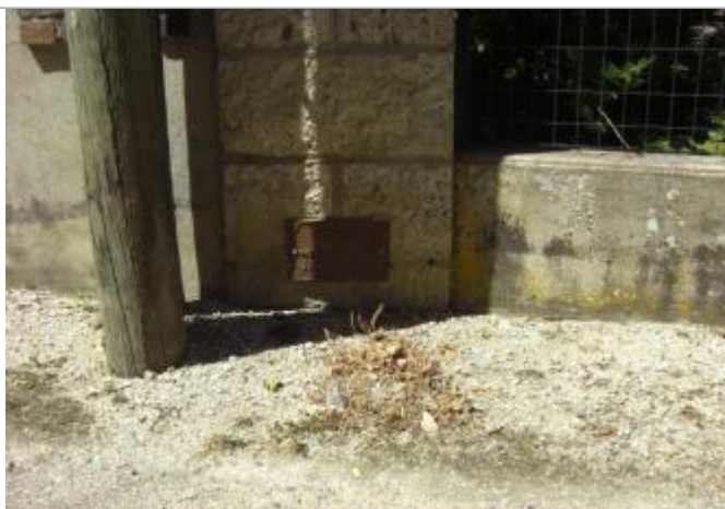
Repère de crue de 1910 - auteur photo : SAFEGE
