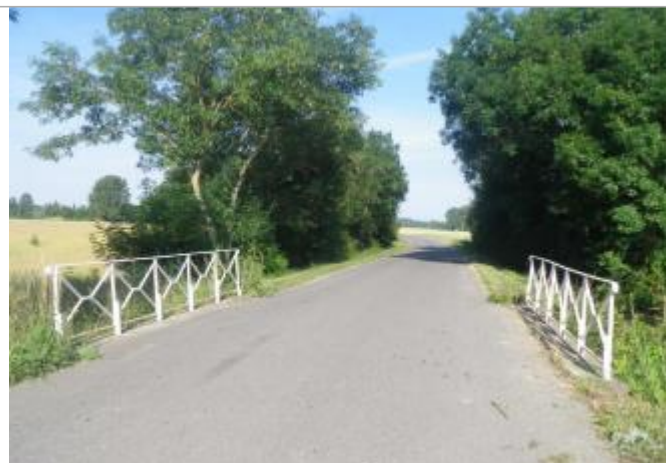
Ponceau à l'entrée du bourg - auteur photo : SAFEGE
