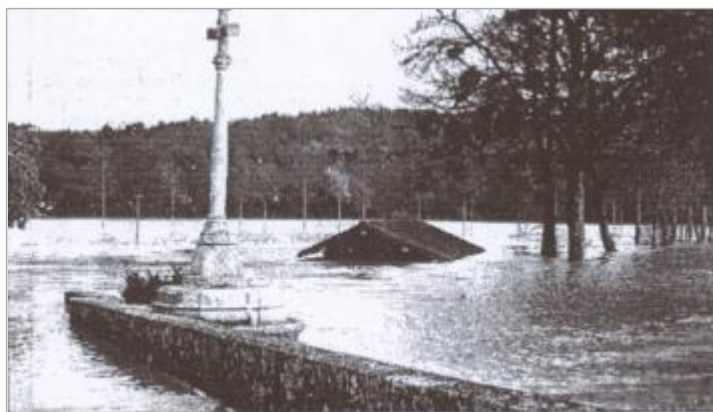
Le village de Cry-sur-Armançon a été coupé en deux. Les jeux pour enfants et le petit chalet situés entre les deux ponts ont été submergés.
