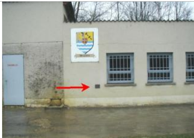
Stade de Chassignelles - auteur photo : SOGREAH
