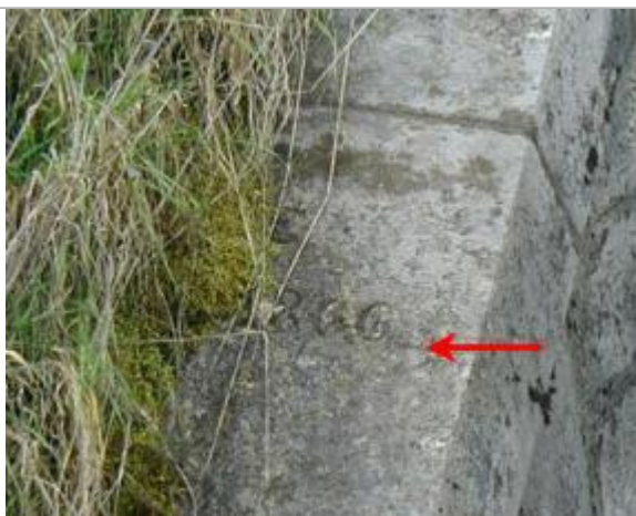
Repère de crue de 1866 - auteur photo : SOGREAH
