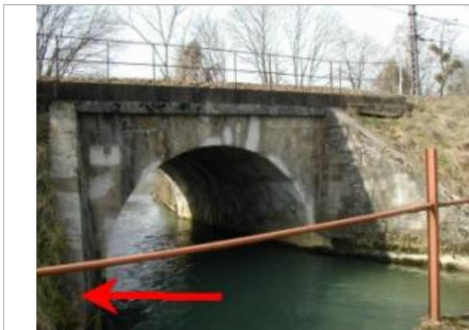
Pont SNCF sur la dérivation de la dérivation - auteur photo : SOGREAH
