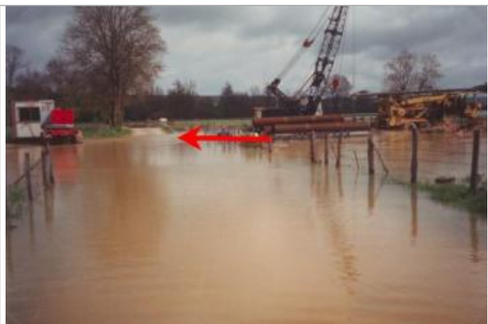
Niveau atteint le 27/04/1998 sur le pont - auteur photo : ?
