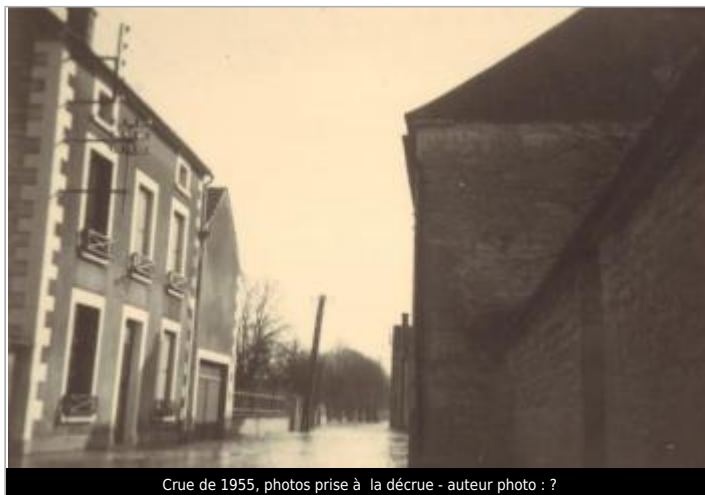
Crue de 1955, photos prise à la décrue - auteur photo : ?
