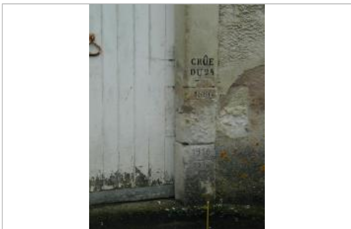
Repères de crue de 1910 et 1866 - auteur photo : SOGREAH
