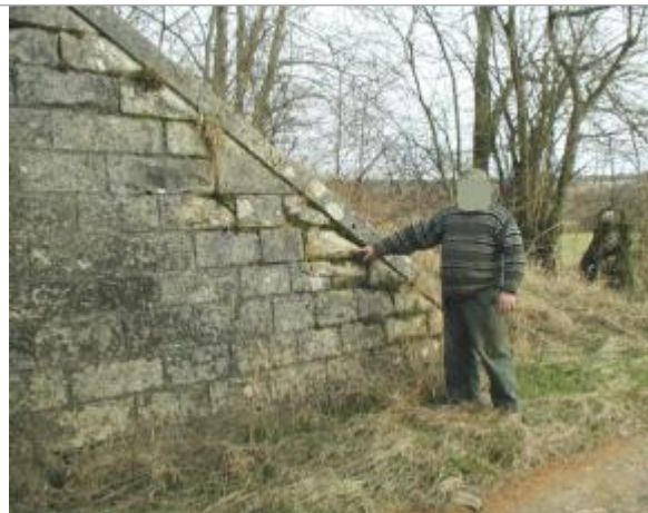
Appui du pont SNCF - auteur photo : SOGREAH
