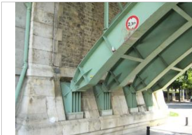
Pont SNCF (RER) - auteur photo : DIREN IDF
