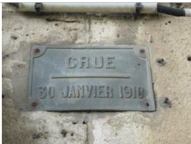
Repère de crue de 1910 - auteur photo : DIREN IDF
