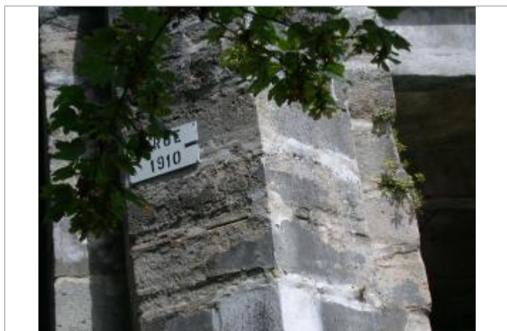
Repère de crue de janvier 1910 - auteur photo : DIREN IDF
