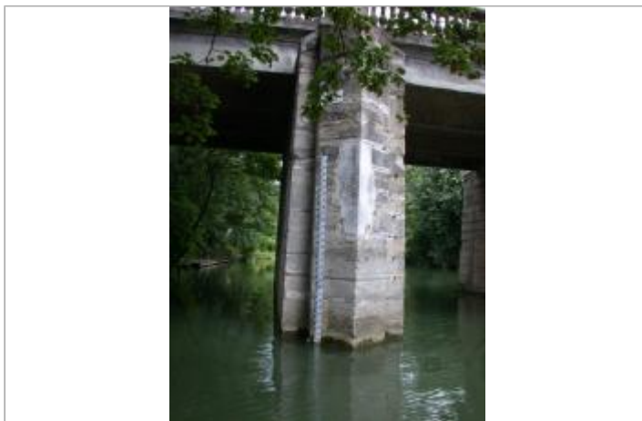
Pont rue du moulin Berson - auteur photo : DIREN IDF
