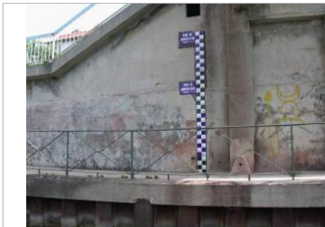
Repères de crue de la passerelle de la Pie - auteur photo : DIREN IDF
