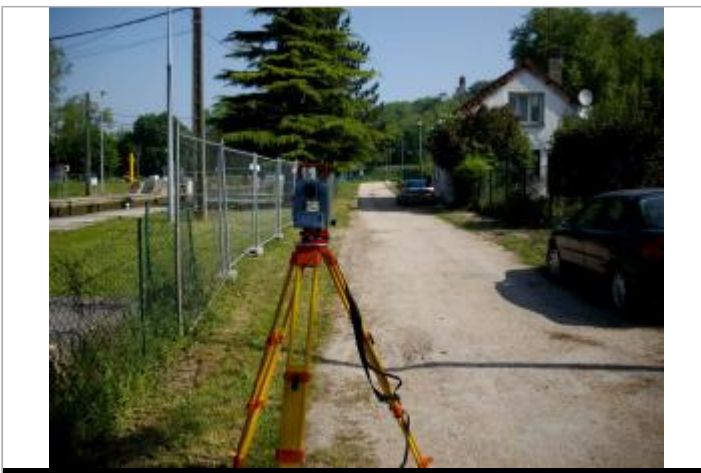
La maison éclusière de Chalifert - auteur photo : DIREN IDF
