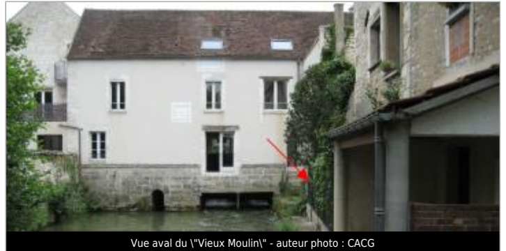
Vue aval du \"Vieux Moulin\" - auteur photo : CACG
