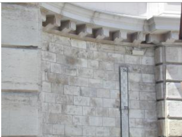
Mur soutènement du pont de Tolbiac, face à l'amont, à l'angle avec le quai Panhard - auteur photo : DIREN IDF
