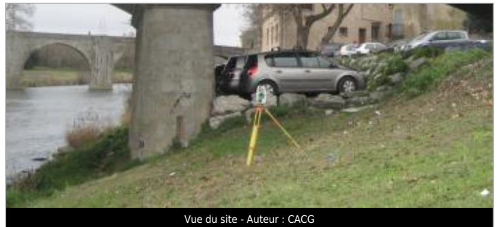
Vue du site - Auteur : CACG
