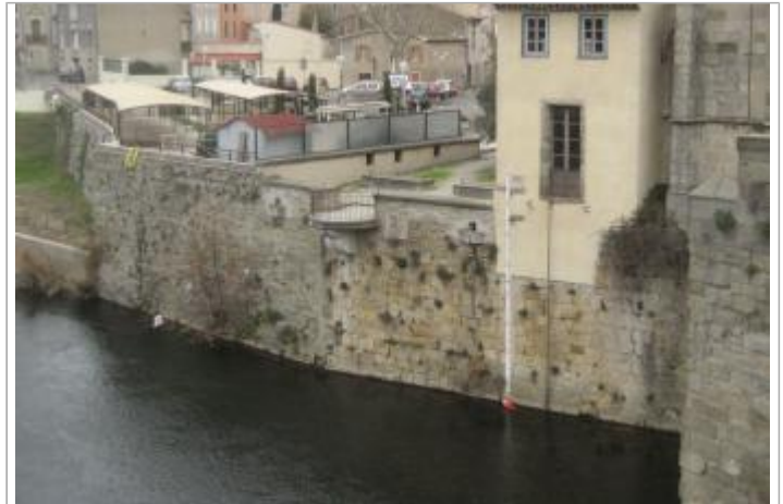
Vue du site - Auteur : CACG
