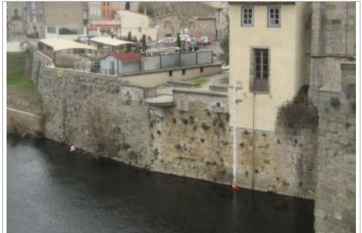
Vue du site - Auteur : CACG
