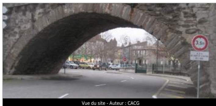
Vue du site - Auteur : CACG
