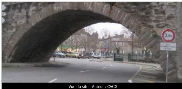
Vue du site - Auteur : CACG
