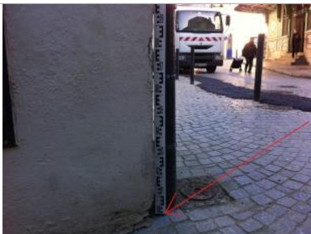
Sol au droit de la gouttière / angle du bâtiment
