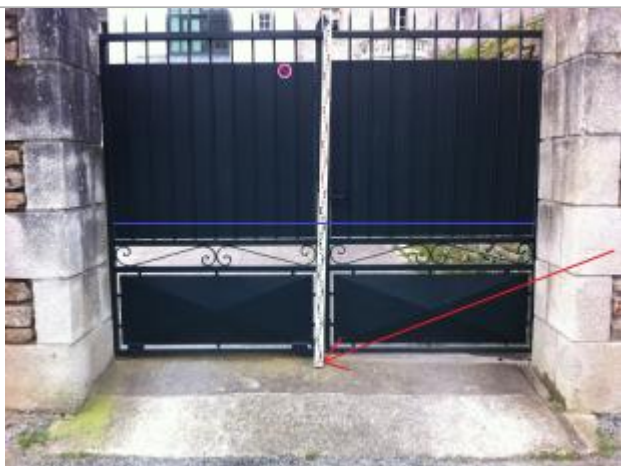
seuil au portail d'entrée dans la propriété
