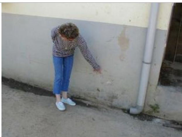
photo du repère (SAFEGE 2004)
