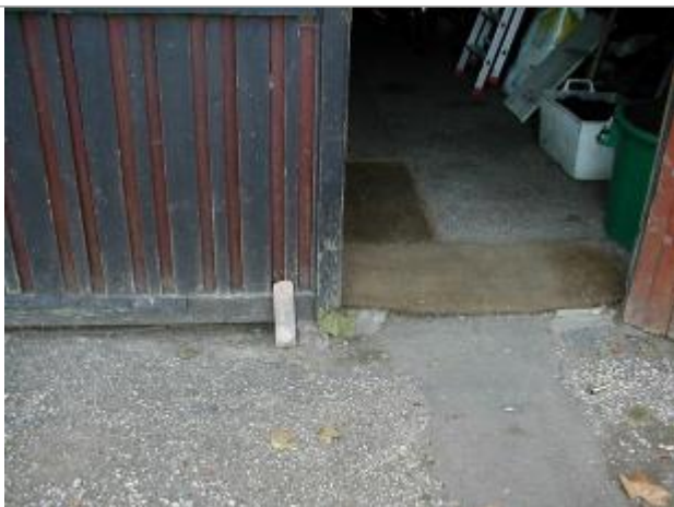
photo du repère (SAFEGE 2004)
