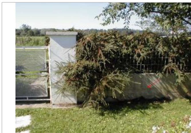
photo du repère (SAFEGE 2004)
