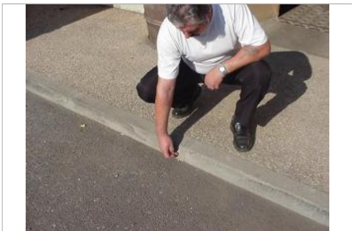
photo du repère (SAFEGE 2004)
