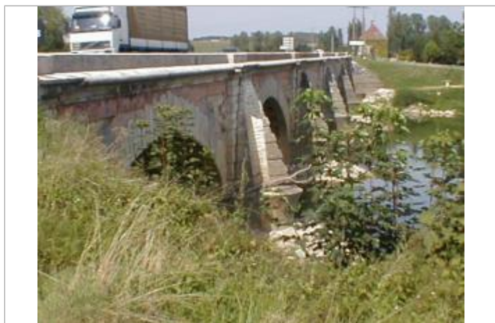
Photo du repère (SAFEGE2004)
