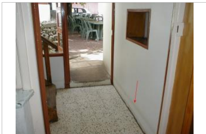
photo du repère (SAFEGE 2004)
