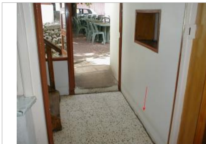
photo du repère (SAFEGE 2004)
