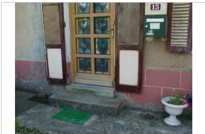
photo du repère (SAFEGE 2004)
