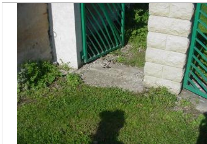
photo du repère (SAFEGE 2004)
