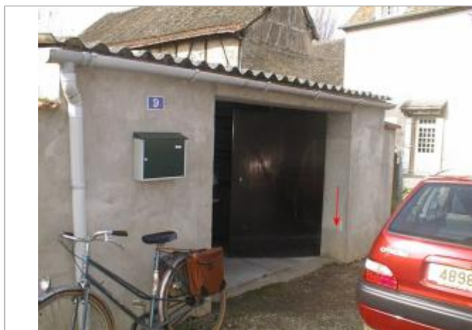
photo du repère (SAFEGE 2004)
