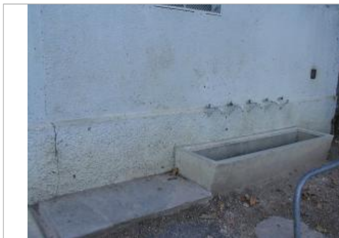
photo du repère (SAFEGE 2004)
