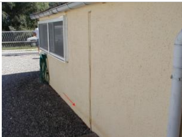
photo du repère (SAFEGE 2004)
