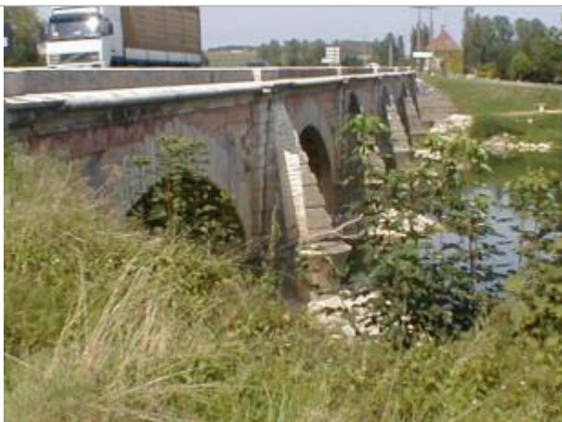
Photo du repère (SAFEGE2004)
