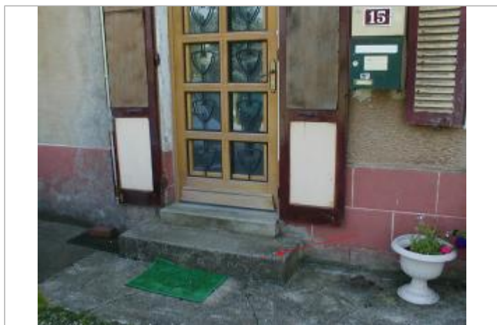
photo du repère (SAFEGE 2004)
