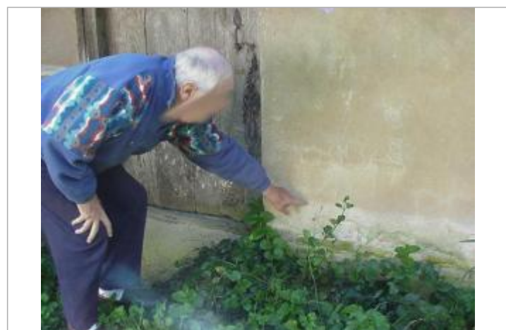
photo du repère (SAFEGE 2004)
