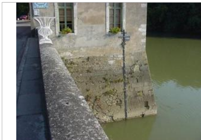
photo du repère (SAFEGE 2004)
