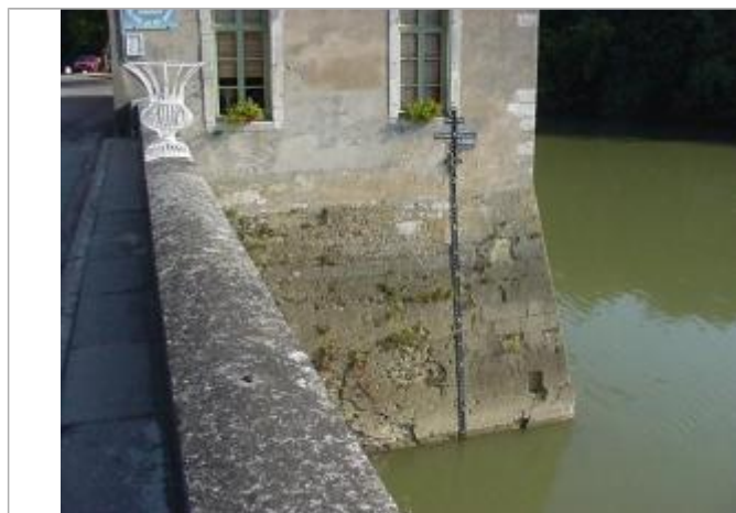
photo du repère (SAFEGE 2004)
