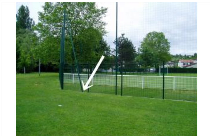
Vue vers l'aval. Sur des poteaux du grillage la crue a déposé une trace de boue.
