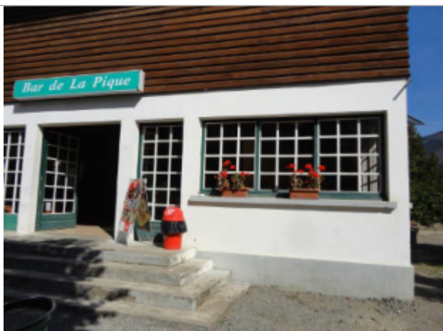
Façade amont du Bar de la Pique
