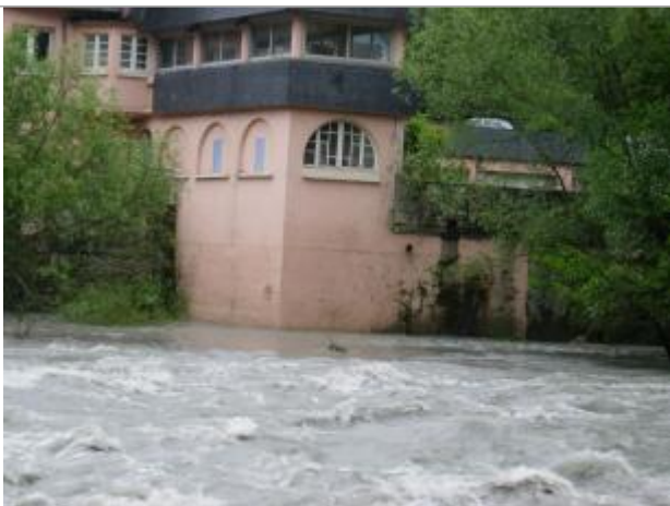
Vue de la façade
