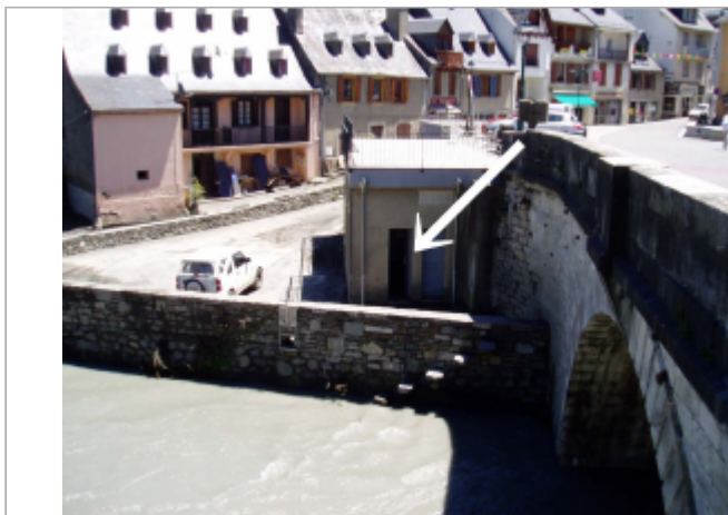
Trace de la crue à l'intérieur des toilettes
